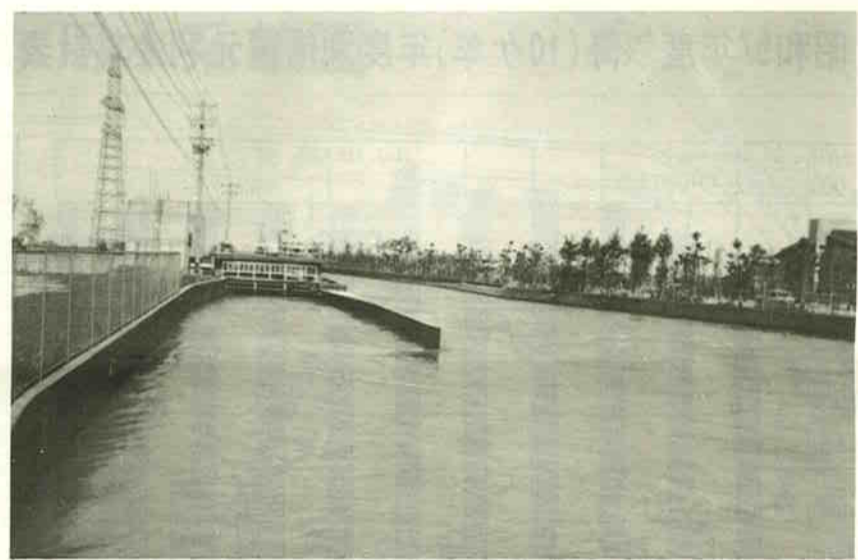
分水比3:1の分水工左側が宮竹用水取入口
