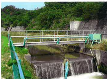
着工前 和気水門
