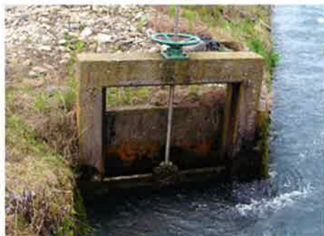
着工前 下郷用水流域水門 (自他保水門)
