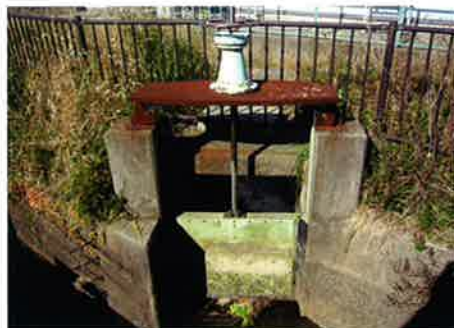
着工前 下郷用水流域水門 (河原新保水門)
