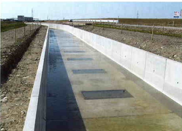
地下水涵養のために設けた水路底の開口部
