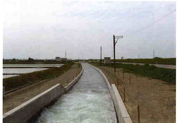
水路部の完成
