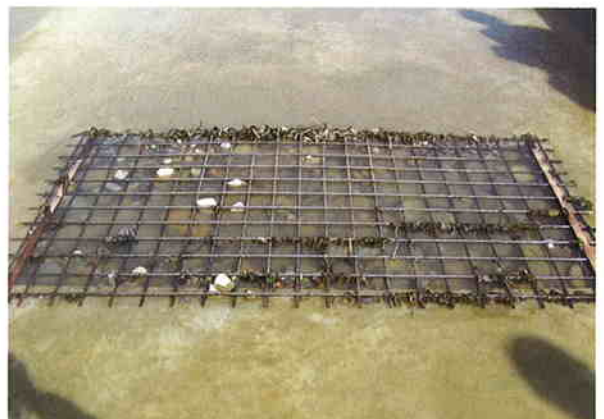
開口部の中には既設石積み水路の石を利用
