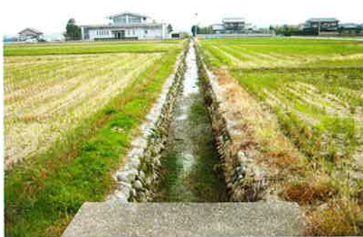
中ノ江用水 水路工
