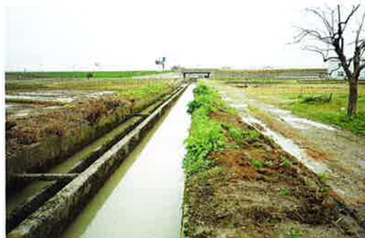
河原用水 水路工
