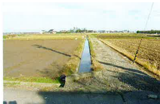
野田北田用水 水路工
