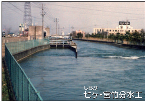
② 手取川から取り入れた用水を七ヶ用水と宮竹用水に分ける施設です。上の写真の左側が宮竹用水です。
