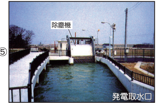
⑤ 発電所で使用する水を取り入れる施設です。ゴミを取り除く除塵機を通った水を地下に埋設された導水管へ送ります。
