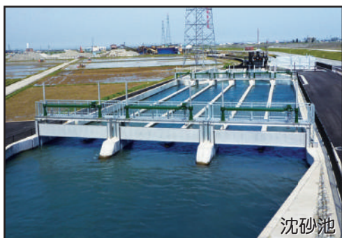
④ 手取川から取り入れた用水に含まれる砂などを取り除くための施設です。川幅を広げて流れる速さを落とすことにより、砂が底へ沈みやすくなっています。
