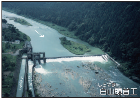
① 手取川を流れる水を取り入れる施設で、宮竹用水のほか七ヶ用水と北陸電力もここで一緒に水を取り入れています。
