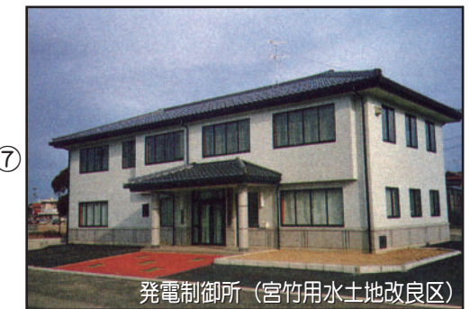
⑦ 発電所は普段は無人で運転しており、宮竹用水土地改良区の事務所に併設の制御所より遠隔監視をしています。
