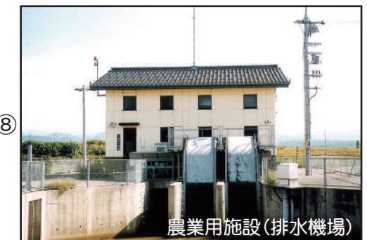
⑧ 宮竹用水第一発電所で作られた電気は、宮竹用水の電動水門や排水機場(ポンプ場)などの農業用施設へ供給・消費され、余った電気が北陸電力へ売電されます。
