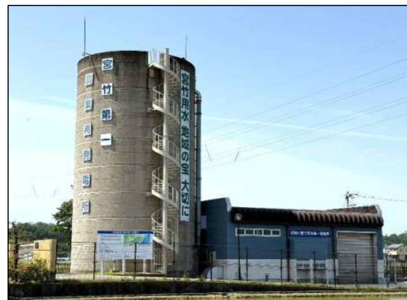
リフレッシュした建屋外装
