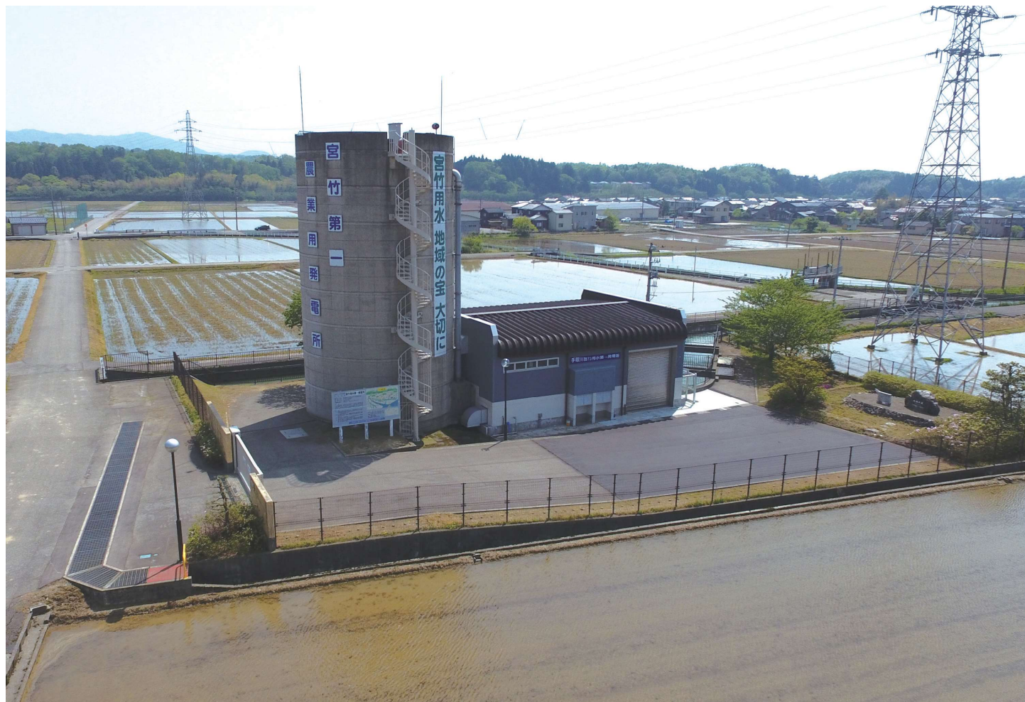
リニューアルした第一発電所【能美市岩内町地内】
