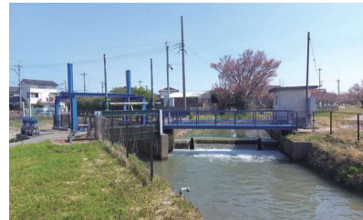
「西川地区」 三反田水門 (小松市大島町地内)
