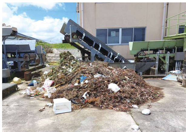
小松市安宅町地内梯川右岸第1排水機場 (除塵機によってあがった草や家庭ゴミ)
